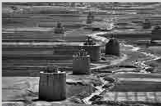
*Kabūtar Khāneh* (la casa dei piccioni), *Kaftar-khaneha*, *Kabotarkhan* o piccionaie sono torri circolari, realizzate in adobe o *pisè* e rivestite da intonaco di fango e paglia. Di dimensioni variabili dai 15 ai 25 metri di diametro, sono sormontate da cupole con piccoli fori a nido d'ape per consentire l'accesso all'interno ai soli piccioni.
